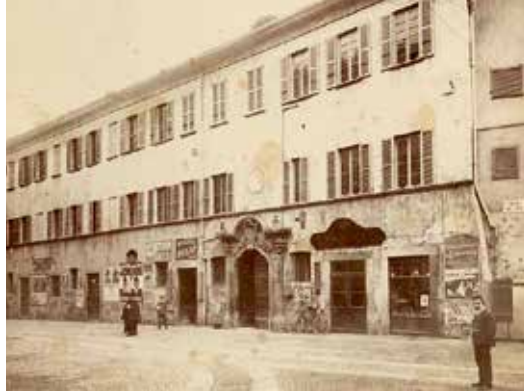
Dello stabile che ospitava il Liceo, demolito nel 1906, resta solo il portale settecentesco murato nella cinta Est del Palazzo degli Studi.
